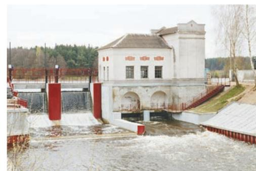
по восстановлению железобетонных конструкций плотины со стороны верхнего бьефа, заменены затворы с установкой подъемных устройств, реконструированы водосливная часть водосбора с днищем, левосторонняя и правосторонняя рисбермы и береговые от-
