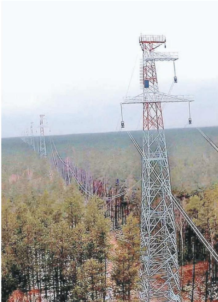
Над лесом прошел участок ВЛ на повышенных опорах 8-го пускового комплекса схемы выдачи мощности
