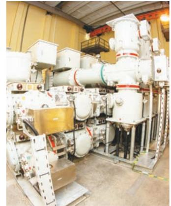
24–25 марта после завершения монтажных и пусконаладочных работ в схеме выдачи электрической мощности ГТУ-25 элегазовое комплектное распределительное устройство КРУЭ 110 кВ было поставлено под рабочее напряжение по КВЛ (кабельно-воздушным линиям) 110 кВ ТЭЦ-26 – ТЭЦ-1.
