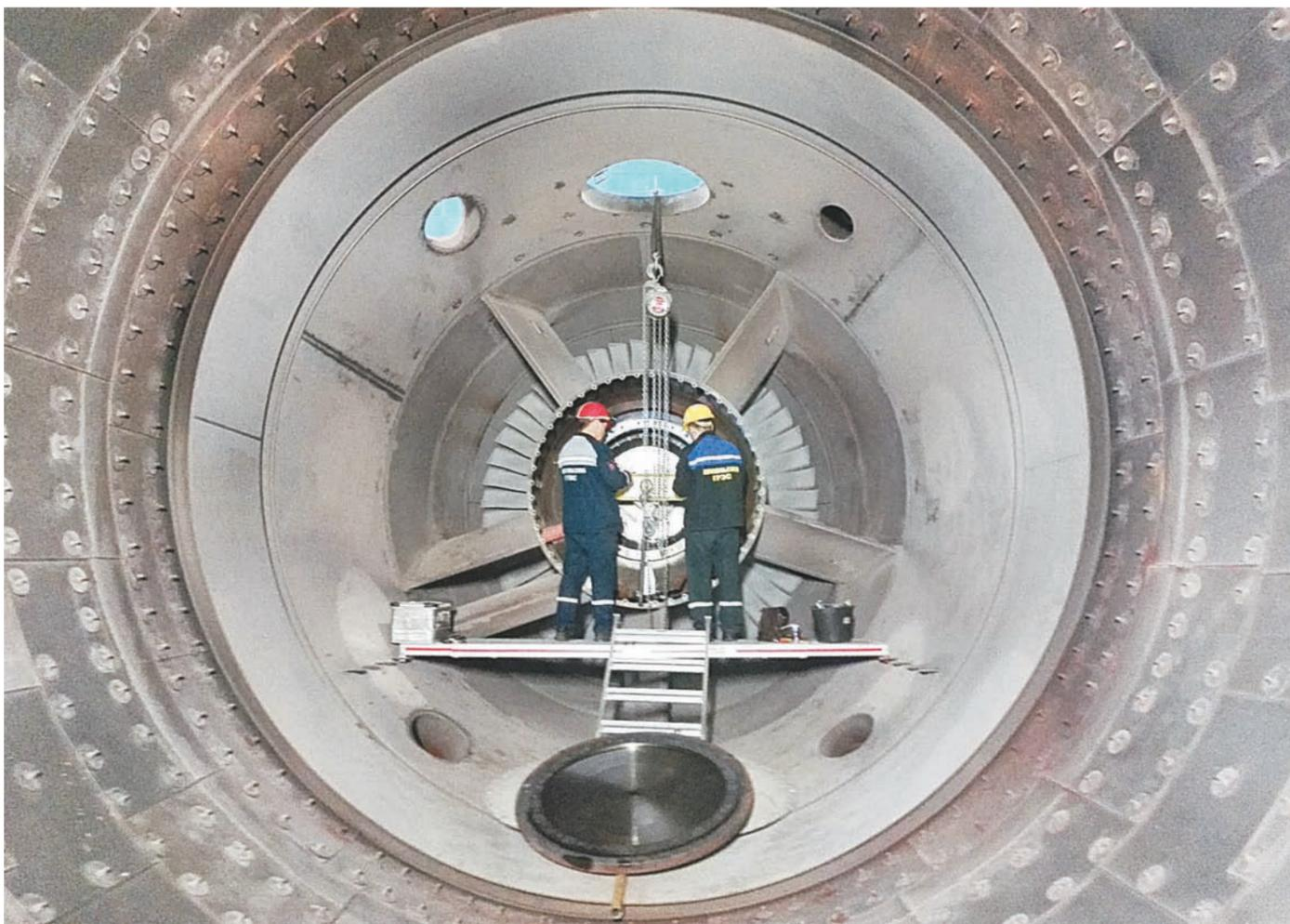
Установка и наладка датчиков механических величин первого подшипника ПГУ
