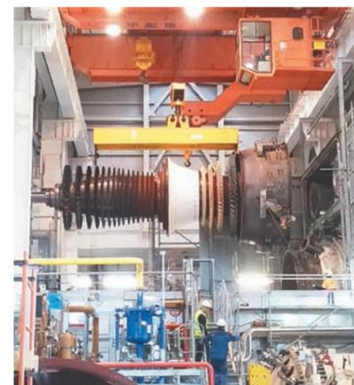
Выемка ротора газовой турбины ПГУ мощным мостовым автокраном
