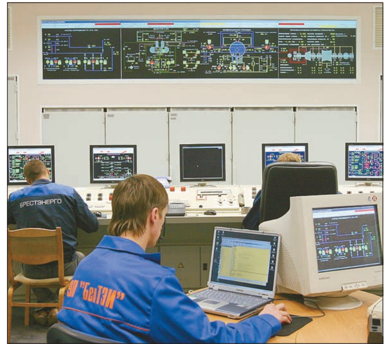
Отладка АСУ ТП энергоблока №4 Березовской ГРЭС, 2003 г.
