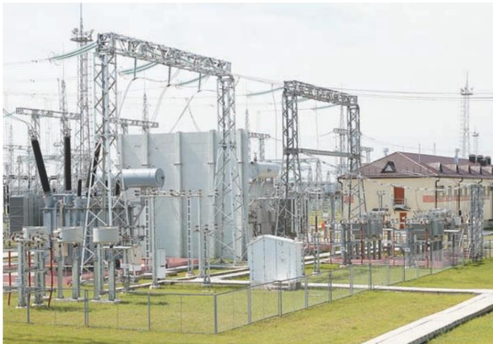
ПС «Поставы». На переднем плане — автотрансформатор №2, за бетонной шумопоглощающей стеной установлен управляемый шунтирующий реактор. На заднем плане — общеподстанционный пункт управления
