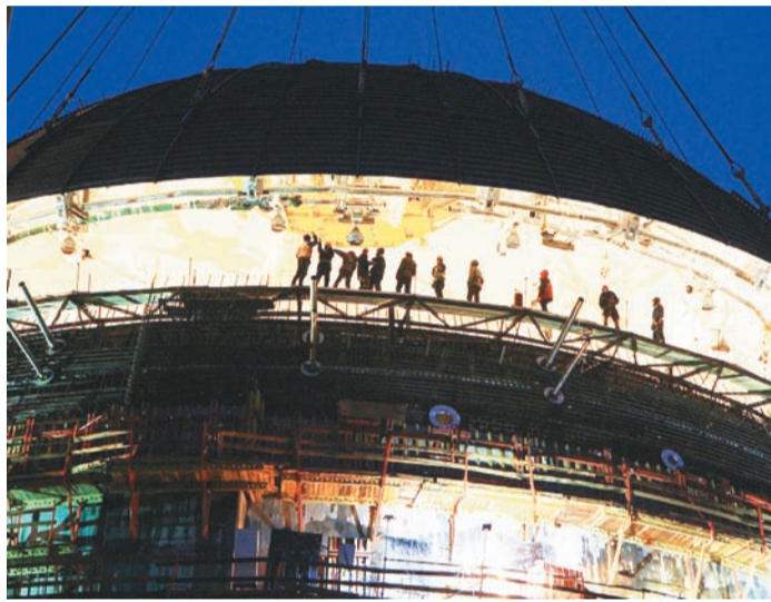
Установка купола внутренней оболочки защиты на энергоблоке №2 Белорусской АЭС
