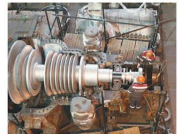
17 января. Подготовка к монтажу основного оборудования турбоагрегата в ремонтной зоне турбинного цеха
