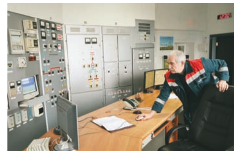
Один из авторов рацпредложения по повышению экономичности работы ДГУЭ – 5000 кВт, машинист блока ДГУ Александр Кузьминич, готовит к запуску детандер-генераторную установку
