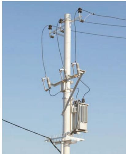
**ХАРАКТЕРИСТИКА ПРОБЛЕМЫ.** В России свыше 50% существующих воздушных линий электропередачи 0,4 кВ находятся в эксплуатации более 30 лет, и в основном они выполнены с применением голых алюминиевых проводов сечением 25–50 мм<sup>2</sup>. На фоне стабильного роста электропотребления в бытовом секторе (около 2% в год), развития социальной инфраструктуры и активного технологического присоединения новых потребителей выявился ряд проблем существующих ВЛ 0,4 кВ, основными из которых являются:
