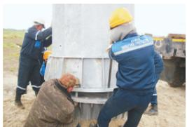
**2009 г.** — специалисты «ЗЭСС» впервые в Беларуси осваивают установку металлических многогранных оцинкованных опор ЛЭП. Такие опоры удобны в транспортировке и применяются в стесненных условиях — например, в городах.
