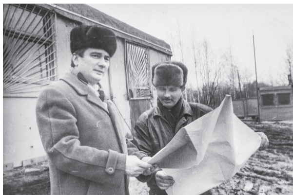
Строительство базы тепловых сетей
