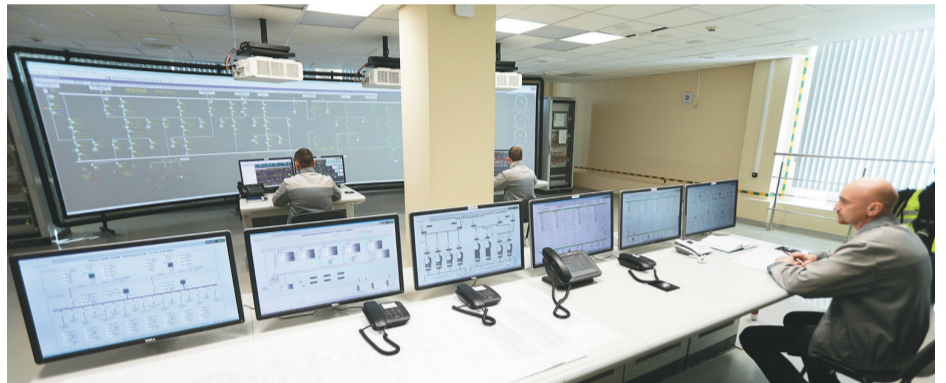
Центральный пульт управления Белорусской АЭС; дежурная смена участвует в эксплуатации и наладке оборудования
