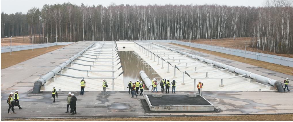
Сооружение доохлаждения брызгального типа глубиной 3 м, шириной 31 м и длиной 170 м, предотвращающее температурное загрязнение реки
