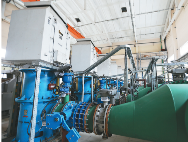
Шесть мощных насосов, которые заимствуют воду из Вилии на нужды Белорусской АЭС
