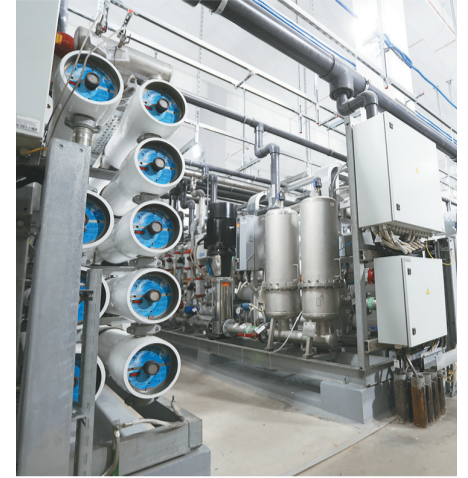
Современная установка обратного осмоса в здании водоподготовки энергоблока №1
