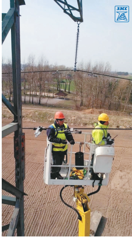
Владимир Ковалевич с польским коллегой демонтируют провод с автовышки
