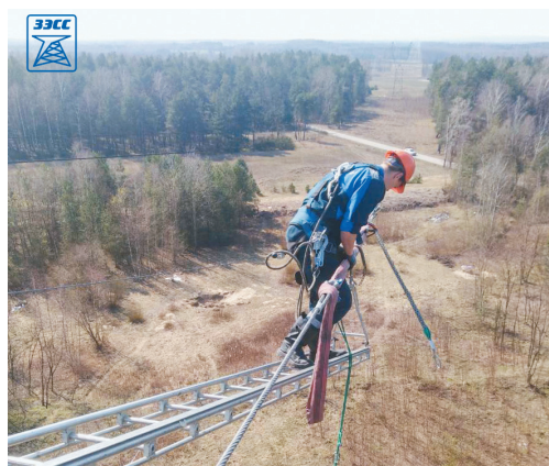
Владимир Сычевский готовится к присоединению изолятора к новому проводу
