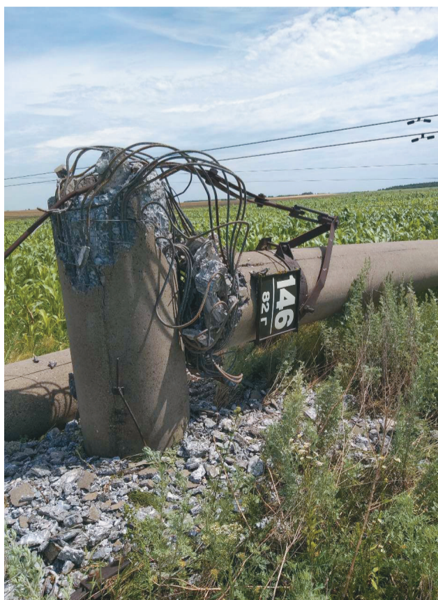
В РУП «Гомельэнерго» впервые столкнулись с такой ситуацией по масштабу повреждений и отключений. Всего в Гомельской области в результате урагана было повреждено 219 бетонных опор, 6 из них — ВЛ 330 кВ.
