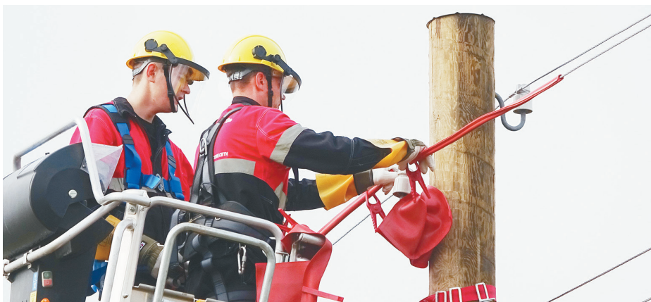
Работа под напряжением на ВЛ 0,4 кВ
