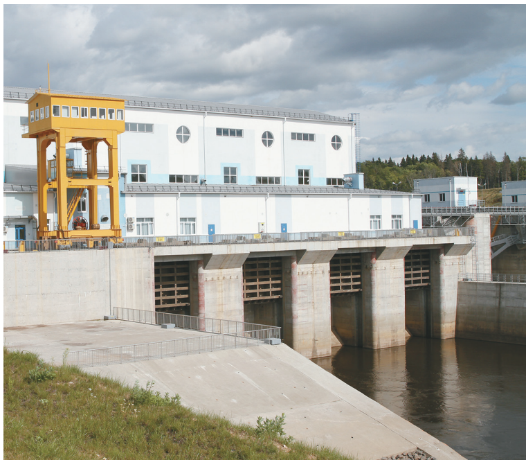
Вид на здание гидроузла со стороны нижнего бьефа
