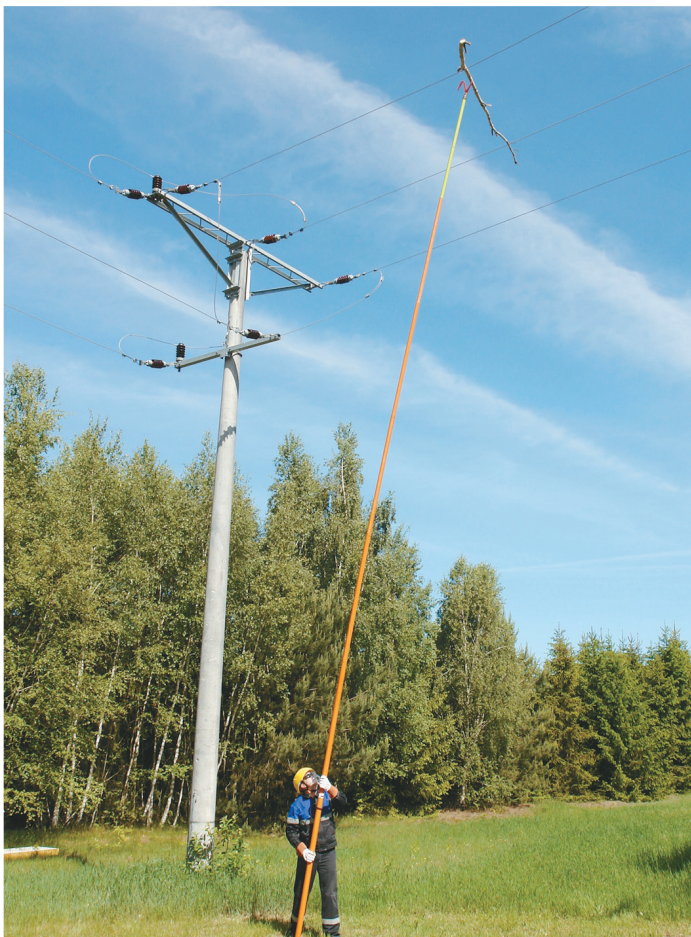
Отработка на полигоне одного из видов работ под напряжением на ВЛ 10 кВ
