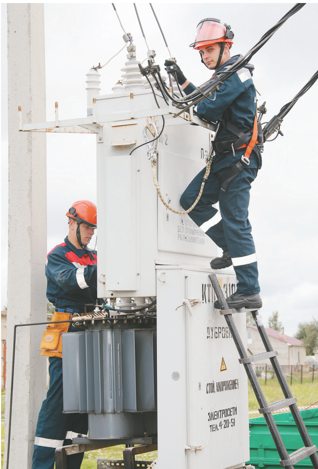
Для бригады Толочинского РЭС замена трансформатора в КТП не в новинку
