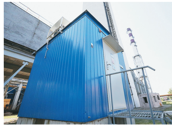
Установка непрерывного мониторинга выбросов загрязняющих веществ в атмосферу передает данные...
