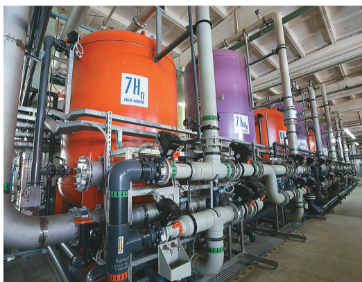
Цепочка обессоливания воды в химическом цехе: здесь вода на Мозырской ТЭЦ проходит трехступенчатую очистку
