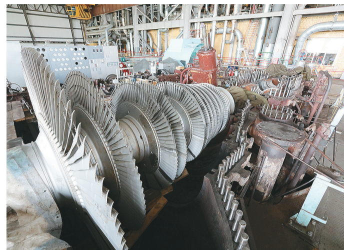
Ротор низкого давления турбины ПТ-135 после реконструкции на заводе-изготовителе АО «УТЗ»
