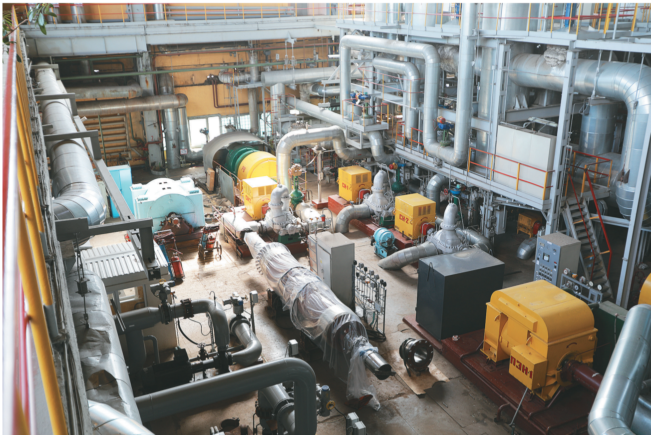
Ротор генератора турбоагрегата №2 на ремонтной площадке станции
