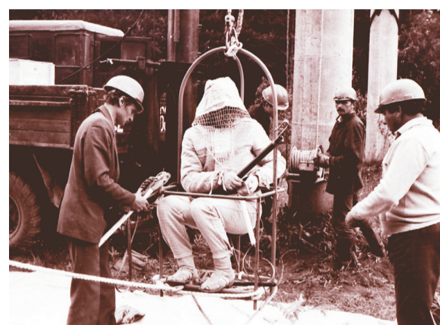
7 июля 1988 г. впервые в РЭУ «Гродноэнерго» были проведены работы по замене изолятора на ВЛ-330 кВ Игналинская АЭС — Молодечно под напряжением персоналом Ошмянских ЭС
