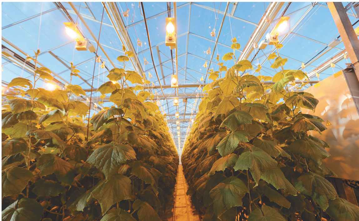
Установка более 5000 светильников заняла полтора месяца при нормативном сроке строительства более 5 месяцев
