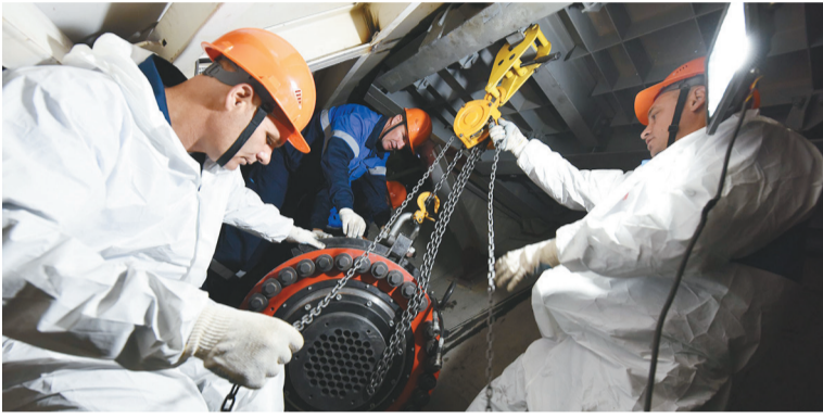
Натяжение пучков арматурных канатов системы преднапряжения защитной оболочки реакторного здания первого блока Белорусской АЭС (Валерия Титова, 2018)
