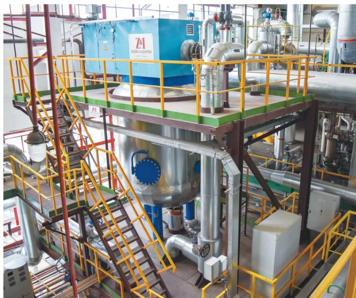
бование совместной работы электрического водогрейного котла и установки аккумуляции тепла. Оно подтвердило работоспособность всего объекта в соответствии с проектной документацией, а также его готовность к участию в регулировании нагрузок энергосистемы после включения в работу Белорусской АЭС.
