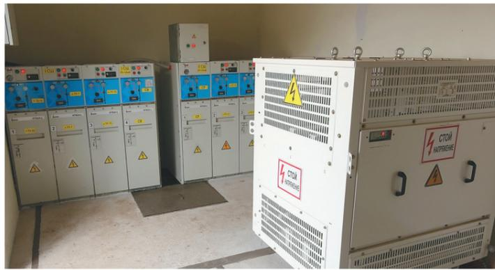
оборудования РУ 10 кВ применяются камеры с вакуумными выключателями, элегазовые выключатели нагрузки различных модификаций и производителей. В РУ 0,4 кВ в основном применяется оборудование системы «Кабельдон». Оно позволяет применять устройства автоматизации и телеуправления, минимизировать эксплуатационные затраты.
