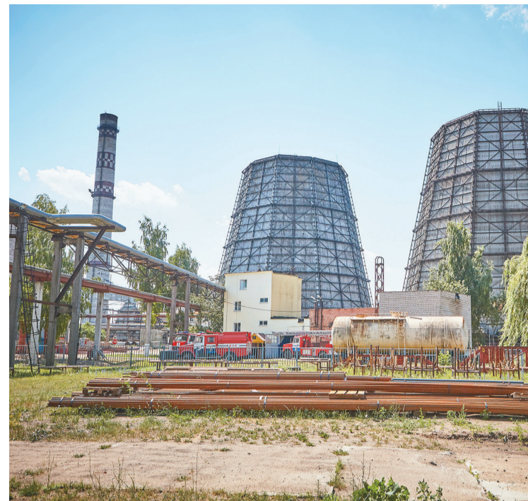
Реконструкция Минской ТЭЦ-3
