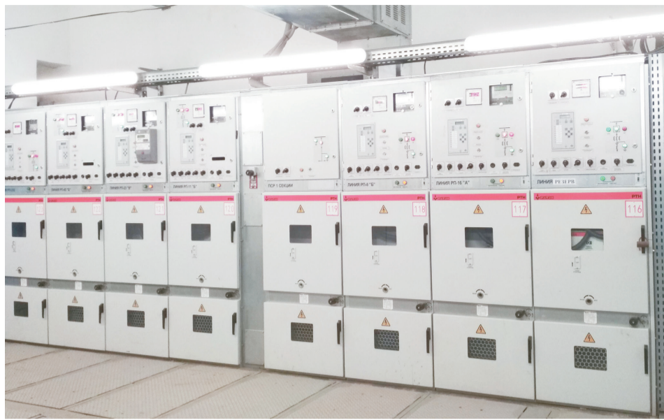
Новая секция ГРУ
