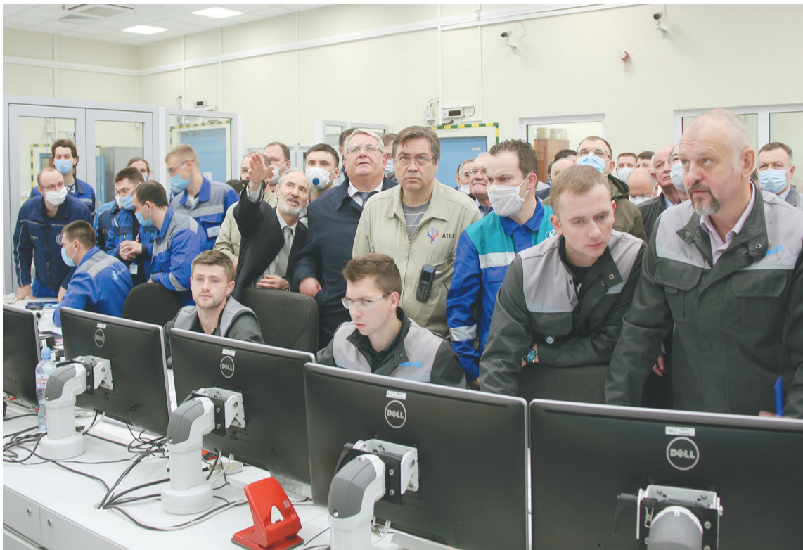
Блочный пульт управления первого энергоблока Белорусской АЭС. Первая синхронизация с сетью и выдача первых киловатт-часов электрической энергии в единую энергосистему Республики Беларусь, 3 ноября 2020 г.
