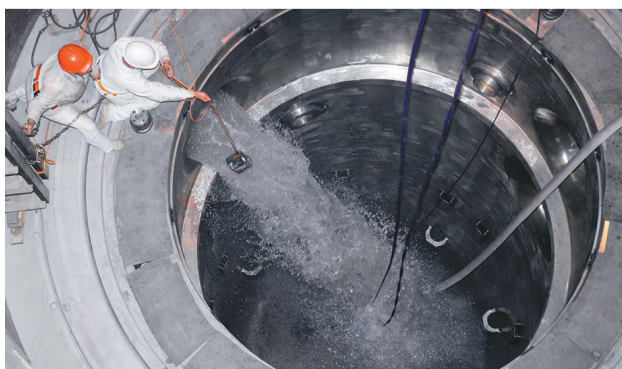
Пролив систем АЭС, 2020 г.
