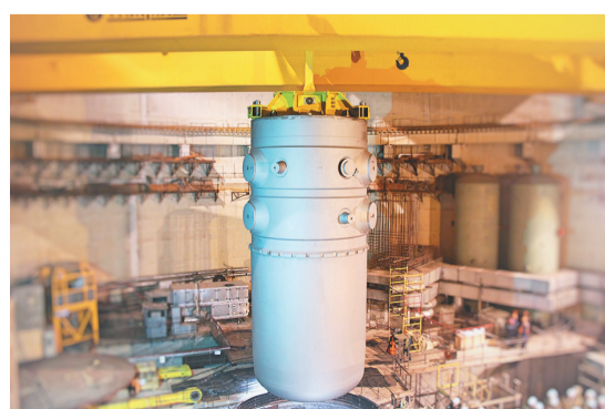
Монтаж корпуса реактора, 2017 г.
