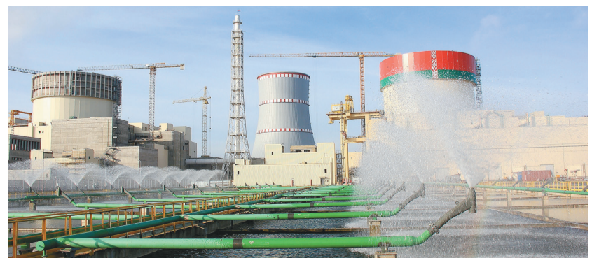
Сооружение доохлаждения брызгального типа 3x31x170 м, 2020 г.
