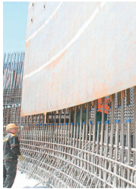
Монтаж защитной об...
