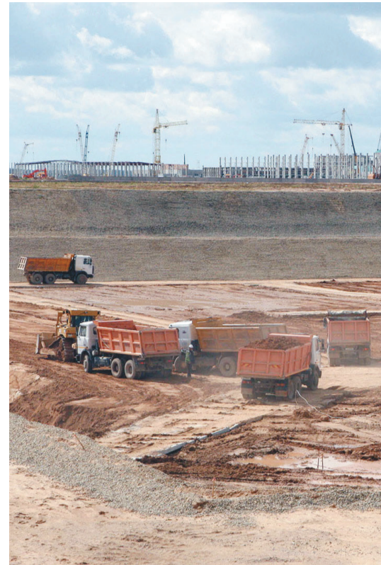
Стройплощадка АЭС, 2012 г.
