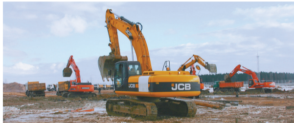
Начало работ на площадке под второй энергоблок
