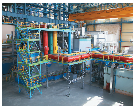
Вид на генератор ГТУ 121,7 МВт на Гродненской ТЭЦ-2 со стороны машзала
