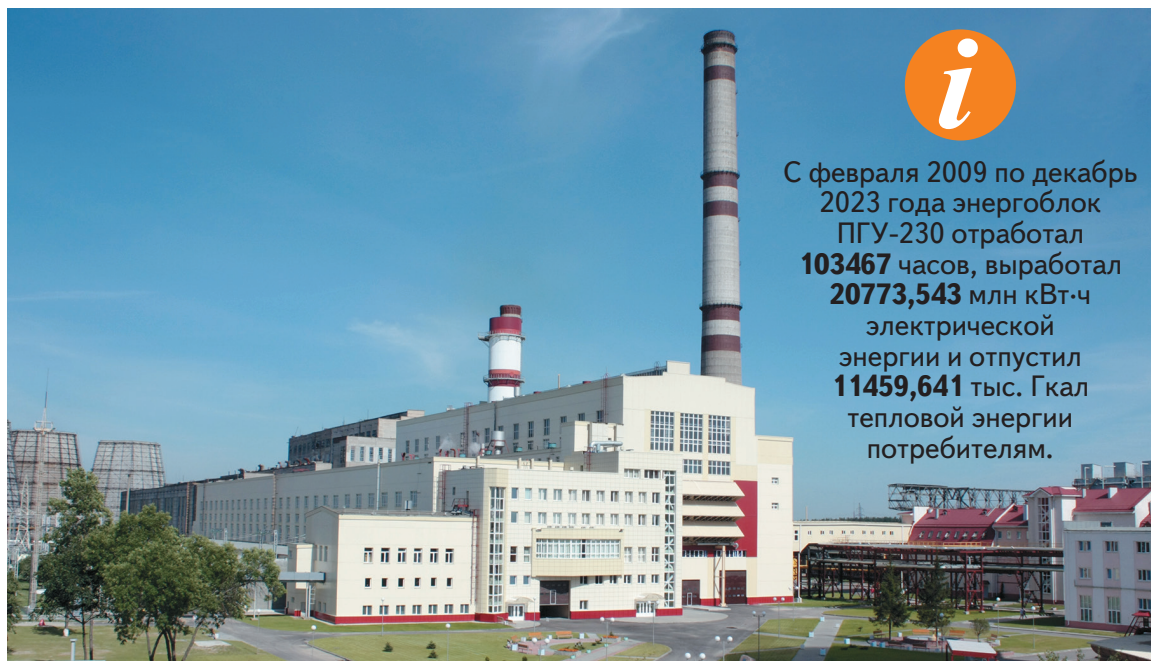
Узнаваемый вид здания цеха парогазовых установок Минской ТЭЦ-3
