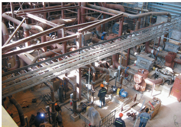
До монтажа вспомогательного оборудования нового энергоблока
