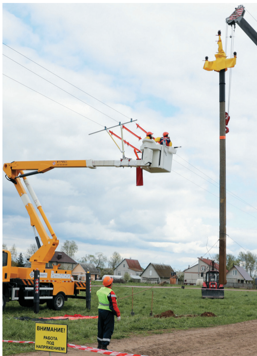
Во время замены опоры провода находятся на временной траверсе, установленной на стреле АГПИ
