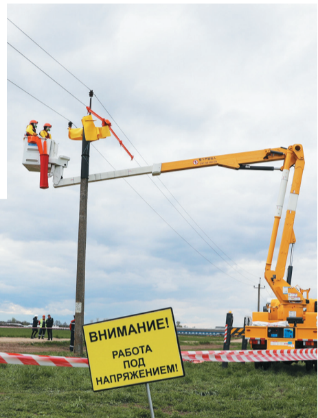
Работы производились методом «в изоляции»
