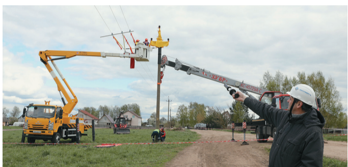
Во время замены опоры провода находятся на временной траверсе, установленной на стреле АГПИ
