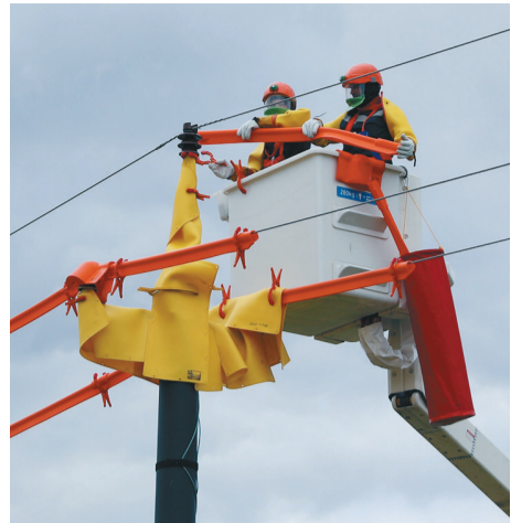
Работы производились методом «в изоляции»
