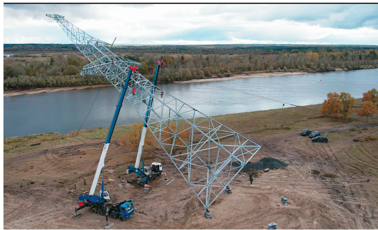
Монтаж стальной анкерно-угловой опоры ВЛ 330 кВ на переходе через реку Припять с использованием двух автомобильных кранов грузоподъемностью по 50 т
