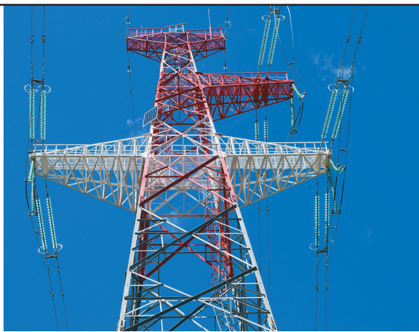
Установленная анкерно-угловая металлическая повышенная опора 330 кВ высотой 60 м для прохождения над лесом
